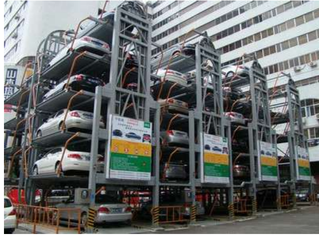
شکل ۲- سامانه چرخشی قائم
